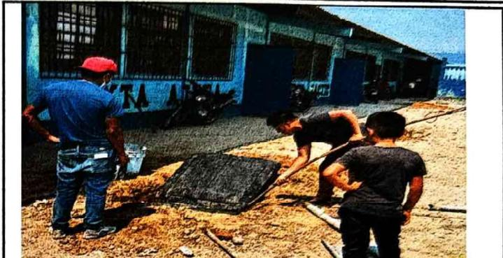
Foto 8: Reestructuración de red de drenaje y cambio de tubería de aguas negras.
